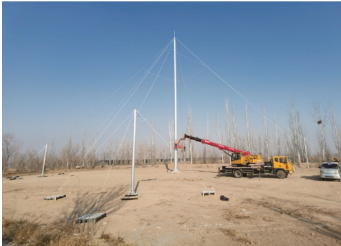
图 3 垂测仪正交 Delta 天线
